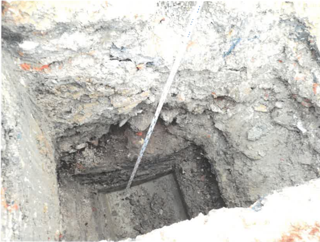
Foto 21: Blick in Schürfgrube SG 6-2
