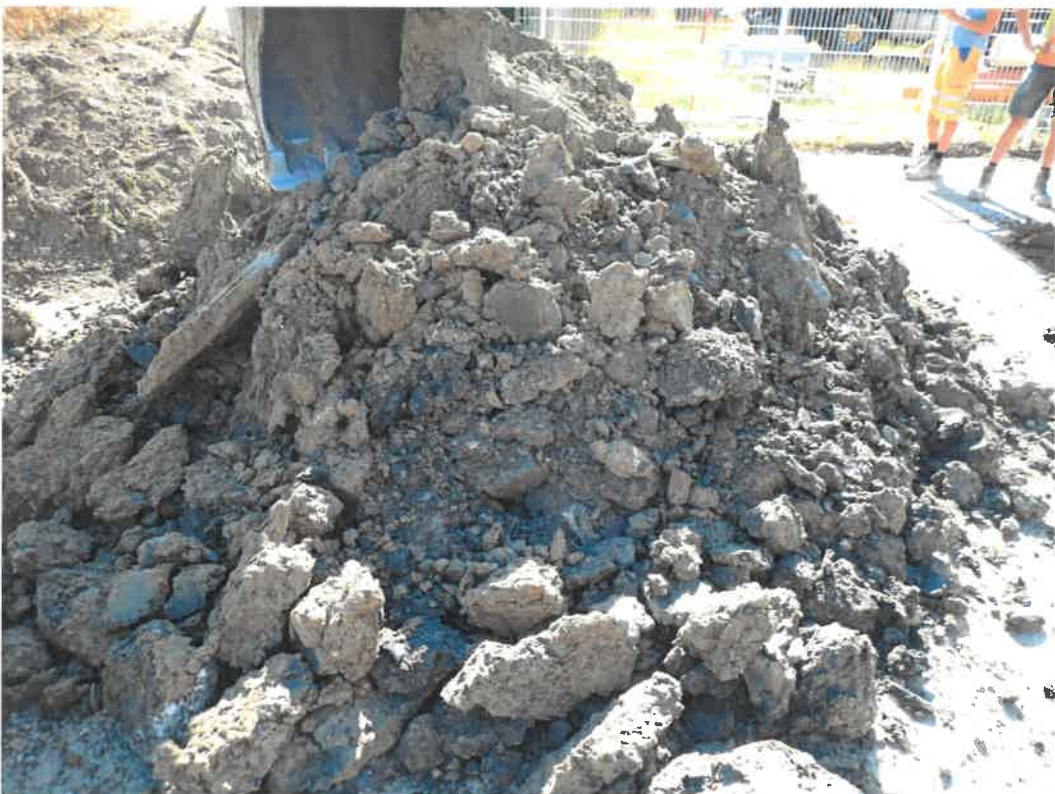
Foto 26: Angefallener Aushub der Schürfgrube SG 8 (Probe: Geislingen SG 8)
