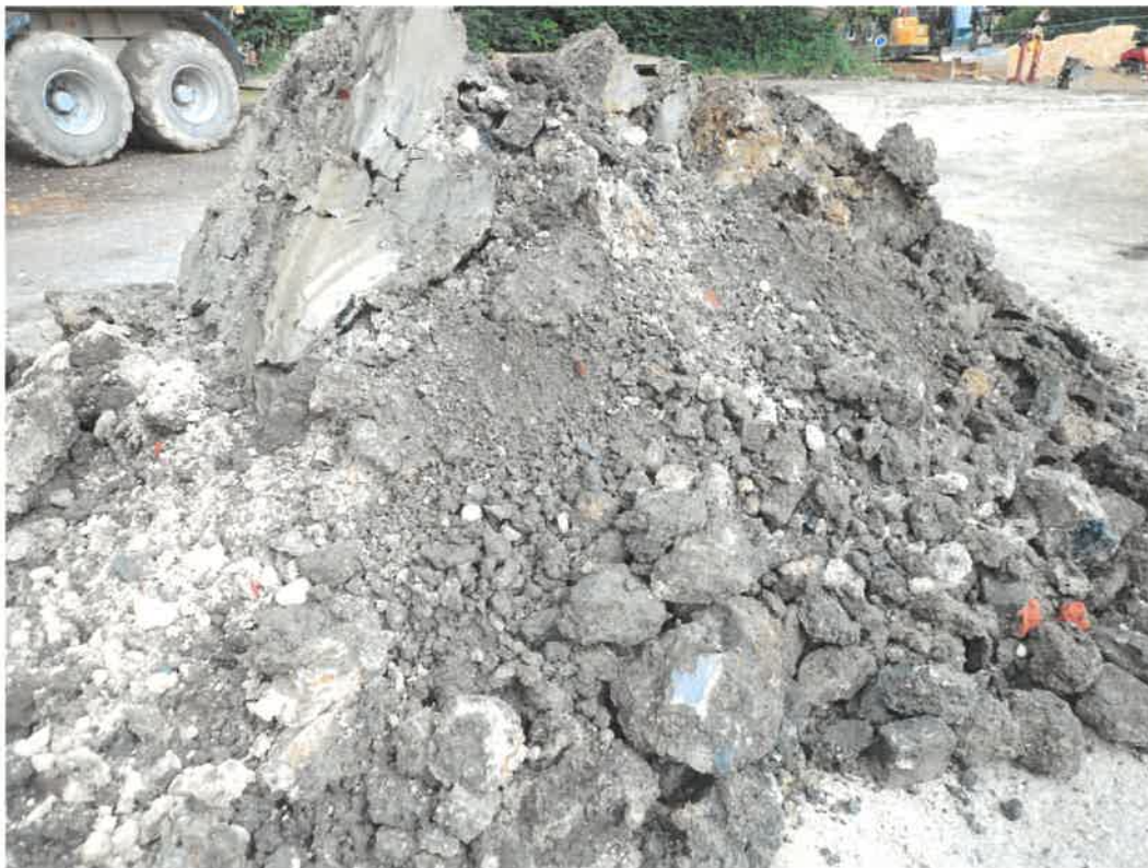
Foto 8: Angefallener Aushub der Schürfgrube SG 3-1 (Probe: Geislingen SG 3-1)
