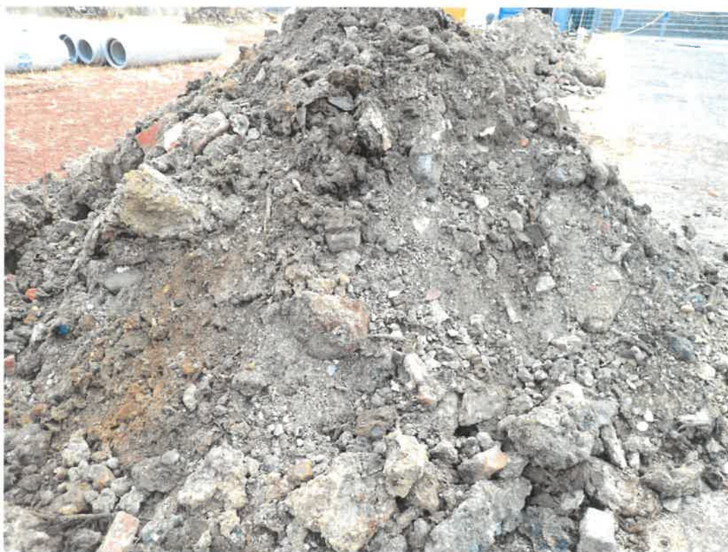
Foto 24: Angefallener Aushub der Schürfgrube SG 7 (Probe: Geislingen SG 7)
