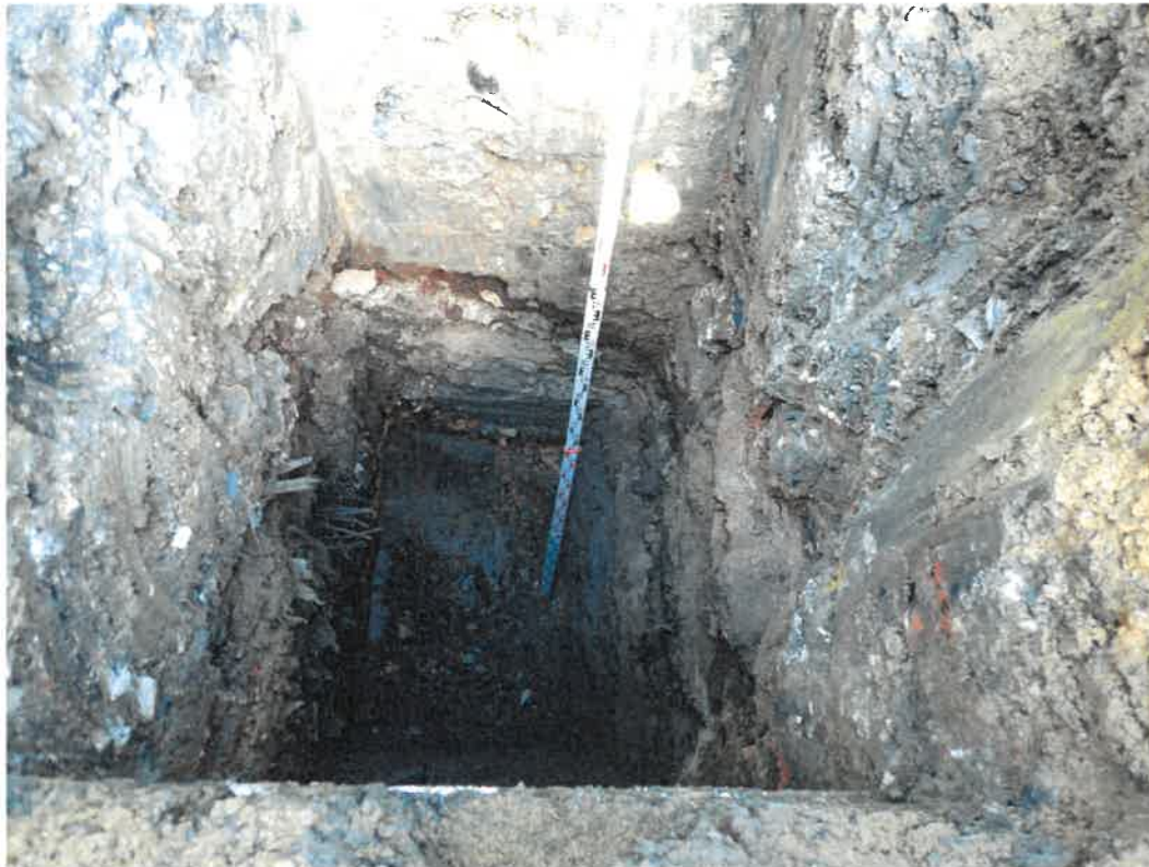
Foto 3: Blick in Schürfgrube SG 1-2
