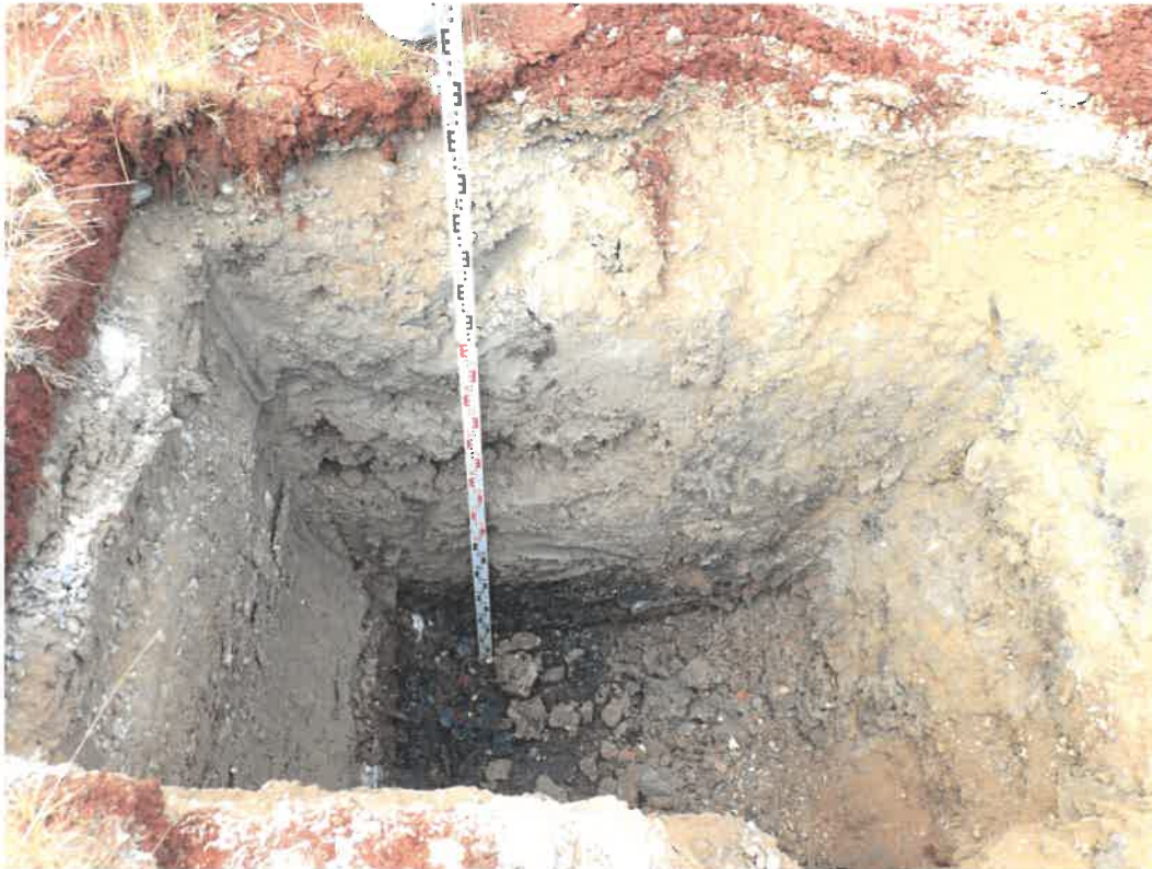
Foto 29: Blick in Schürfgrube SG 10
