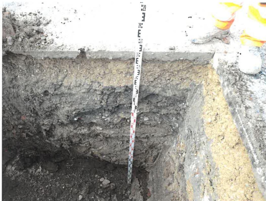
Foto 23: Blick in Schürfgrube SG 7
