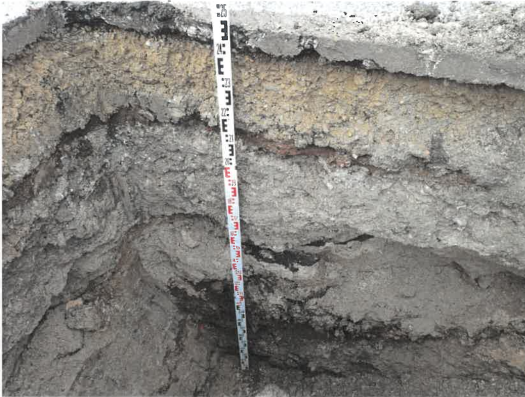
Foto 27: Blick in Schürfgrube SG 9
