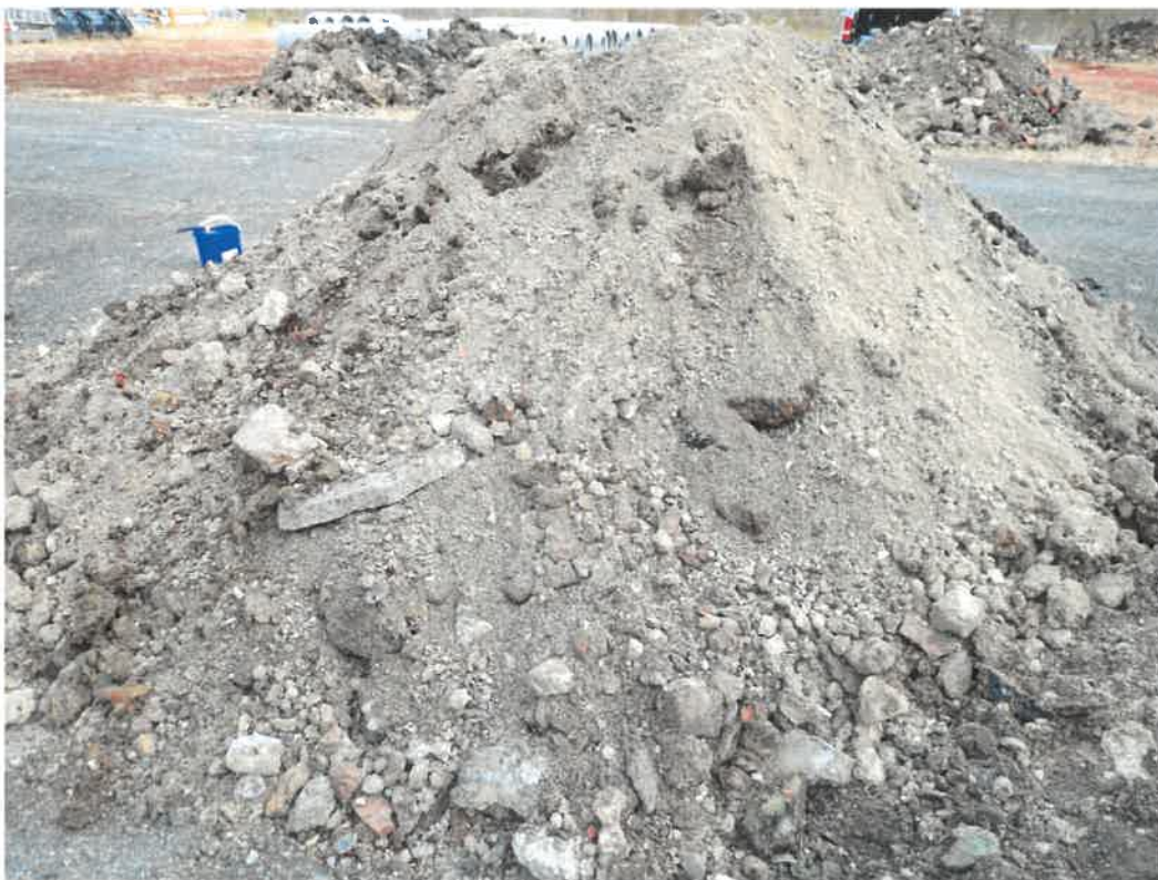
Foto 16: Angefallener Aushub der Schürfgrube SG 5-1 (Probe: Geislingen SG 5-1)
