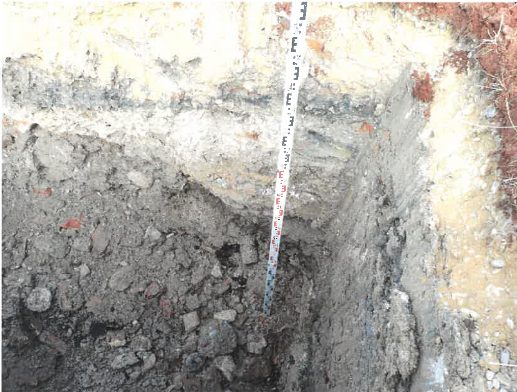
Foto 19: Blick in Schürfgrube SG 6-1
