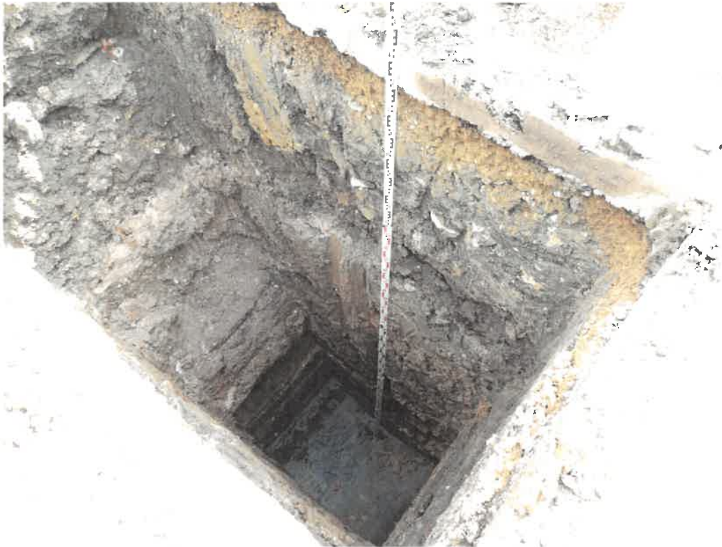
Foto 9: Blick in Schürfgrube SG 3-2
