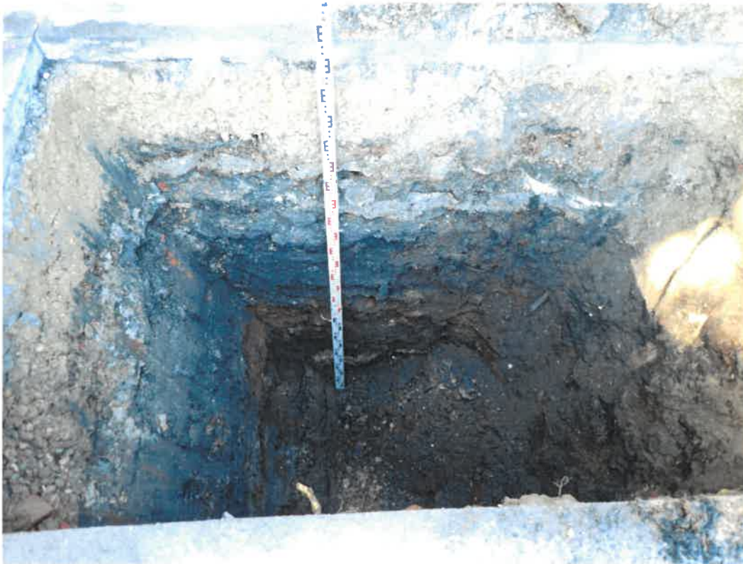
Foto 31: Blick in Schürfgrube SG 12
