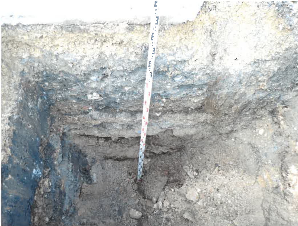
Foto 15: Blick in Schürfgrube SG 5-1
