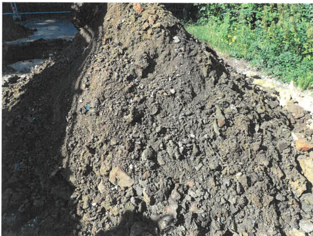
Foto 2: Angefallener Aushub der Schürfgrube SG 1-1 (Probe: Geislingen SG 1-1)
