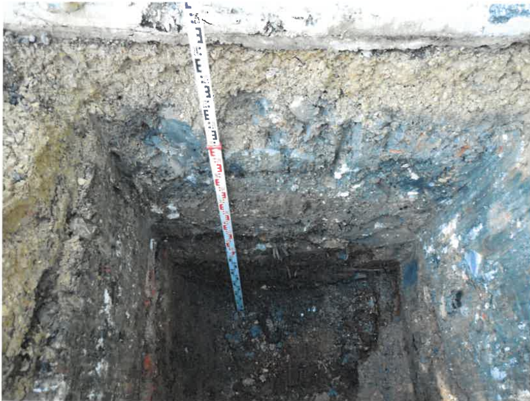
Foto 1: Blick in Schürfgrube SG 1-1
