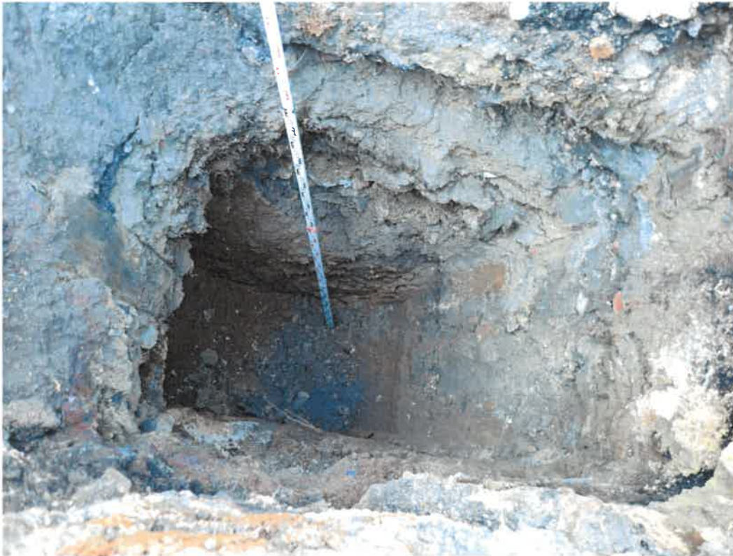
Foto 13: Blick in Schürfgrube SG 4-2
